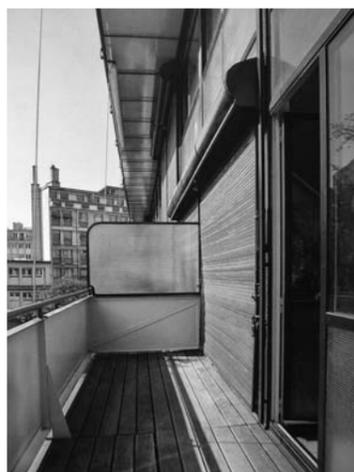
Façade sud. Balcon restauré. Structure métallique renforcée, couleurs d'origine restituées, stores réparés et système d'enroulement motorisé. Sol renové selon dispositif en longueur d'origine.
