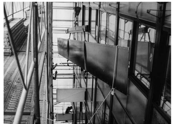
Démontage des balcons. Les éléments structurels étaient dans un tel état de corrosion que leur restauration *in situ* était impossible. Ils furent soigneusement démontés et restaurés en atelier. Photographies Bernard Zumthor
